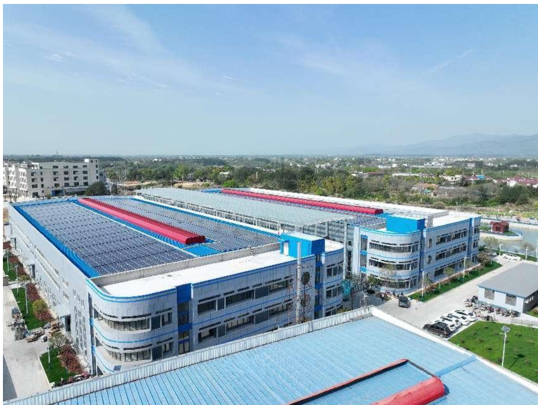
车间屋顶光伏发电
