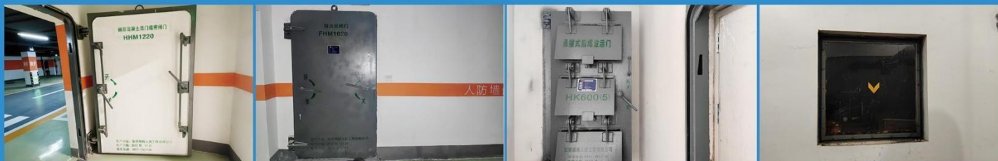
钢筋混凝土活门槛密闭门
